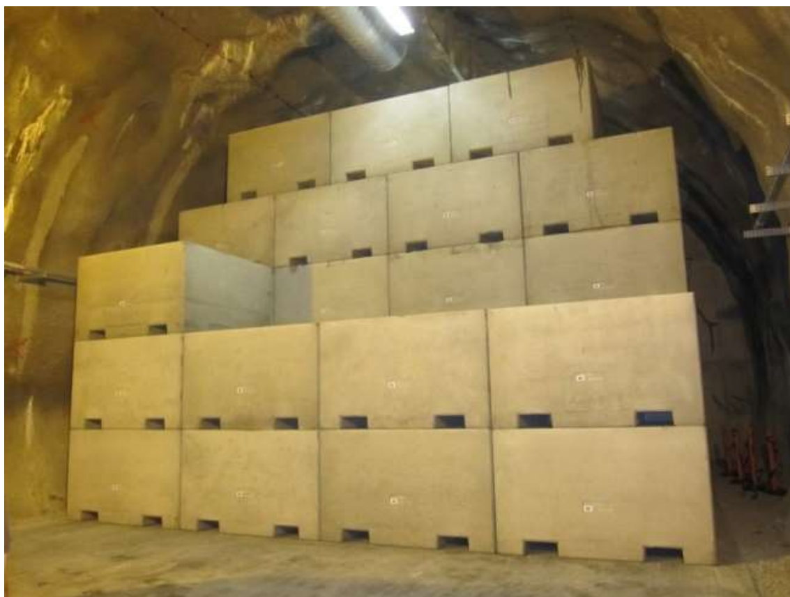
3. ábra: Az I-K1 kamrában elhelyezett betonkonténerek elrendezése
