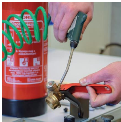
A fejszerelvény kifűvése sűrített levegővel
