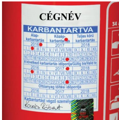
Karbantartást igazoló címke felhelyezése OKF azonosító jellel
